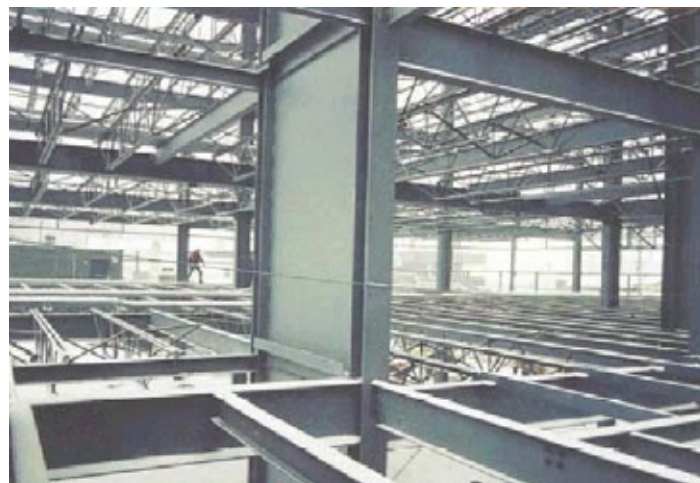
Τυπικός φέρον οργανισμός με μεταλλικά τοιχώματα
