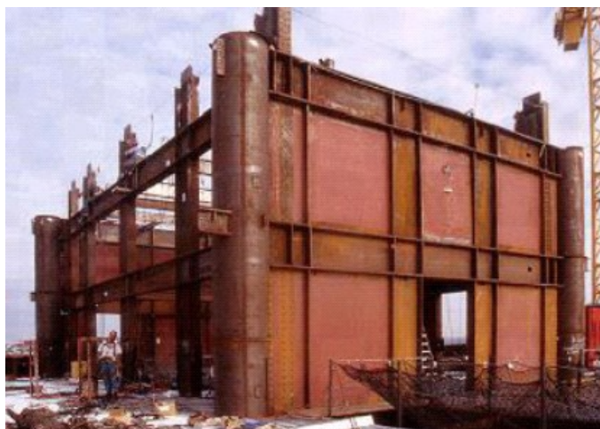
Τυπικός φέρον οργανισμός με μεταλλικά τοιχώματα
