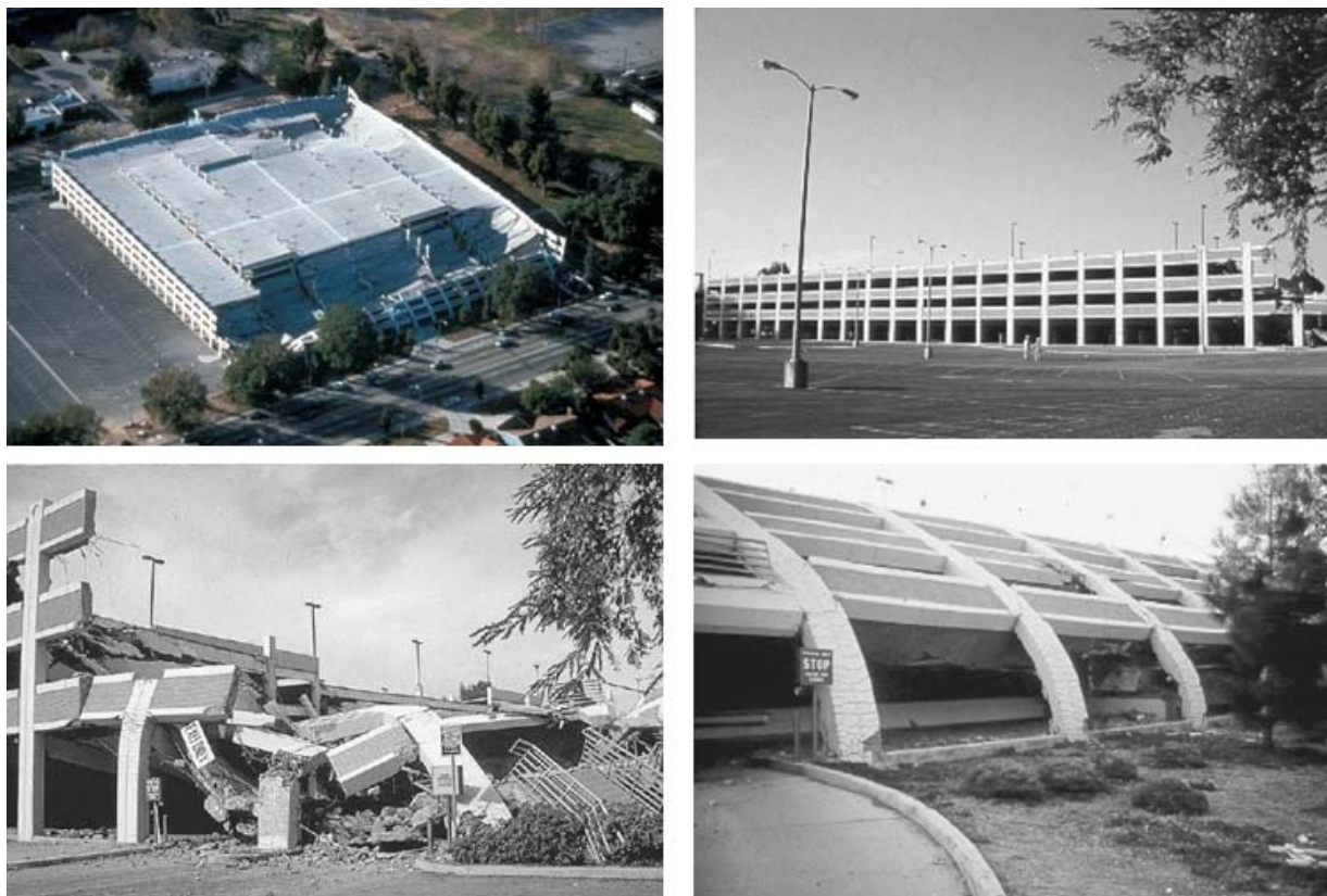
Fig. 13 Colapsul garajului Cal State Northridge
