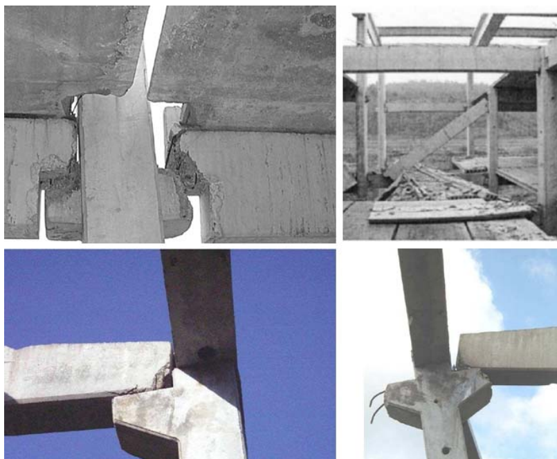
Fig. 4 Avarii la imbinarea stalp-grinda
