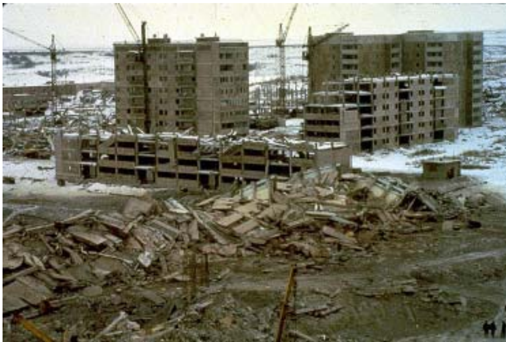
Fig. 16 Colapsul unor cladiri in cadre prefabricate-Spitak (Armenia)
